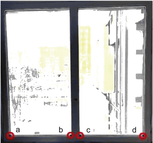
Фото оконного блока с установленным измерительным оборудованием
